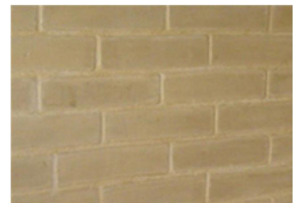
Autres matériaux biosourcés mis en œuvre et étudiés sur le projet : paille, gabion, brique de terre crue comprimée
