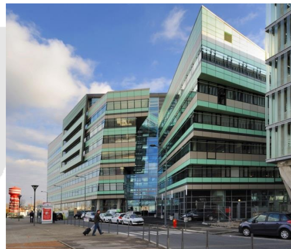
WOOPA - Pôle de la coopération et de la finance éthique Carré de Soie à Vaulx-en-Velin (69) : mission d'Energy management et démarche de commissionnement sur 3 ans après la réception.
