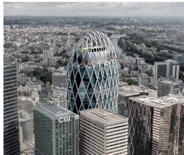
Tour D2 à La Défense – commissionnement avec suivi sur un an après la réception
